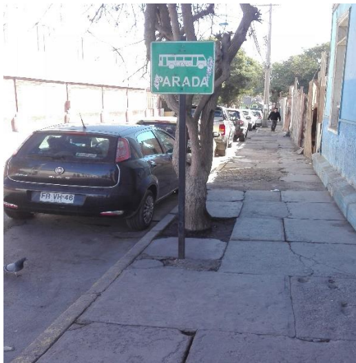
P233; placa dañada y fundición deteriorada.
