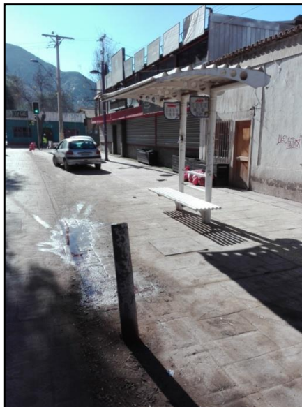
Figura 100 Paradero P114 con fierro que dificulta el acceso.
