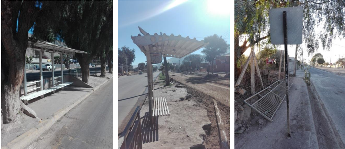
Figura 72 Refugios que no cumplen condiciones de accesibilidad
