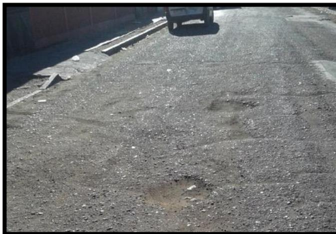
**(C-38) Grietas transversales, longitudinales y oblicuas, con desprendimiento de mortero asfáltico. Severidad alta (incluye baches aislados)**
