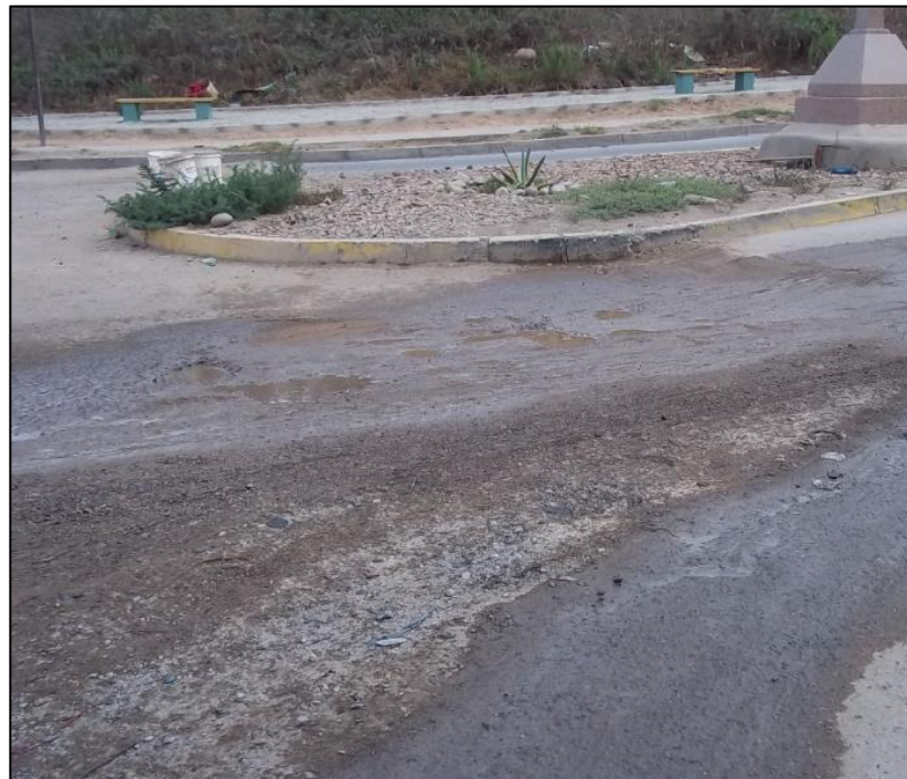
Ilustración 2-1 Imagen Eje Rector Jorge Miranda, Estado “MUY MALO”
