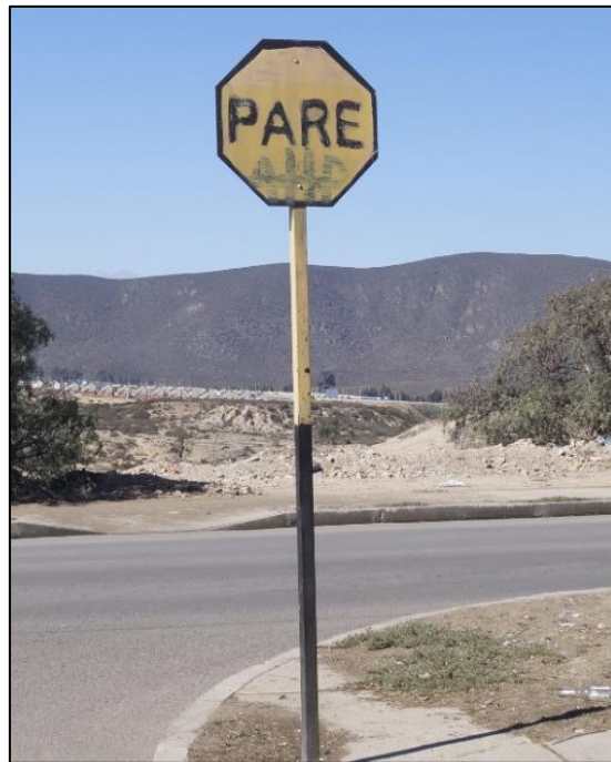
Ilustración 3-3 Imagen Señalética eje San Francisco, San Juan. Estado “MALO” (Reg. N° 1791)
