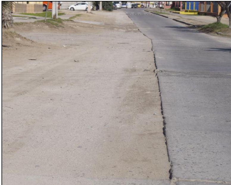
Ilustración 2-3 Imagen Eje las Azucenas, Sindempart. Estado “Muy Malo”
