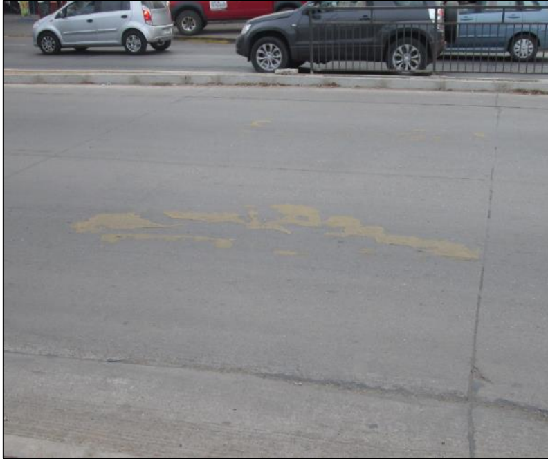
Ilustración 4-32 Imagen demarcación, AV Balmaceda. Estado de conservación “MALO”
