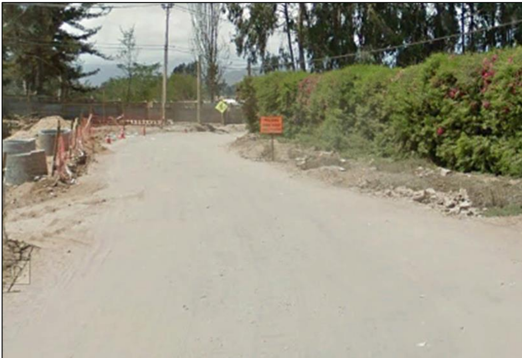
Ilustración 2-5 Eje Rodolfo Wagnechkt, San Joaquín. Estado “MUY MALO”.
